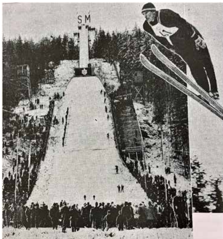
Kullerbergbakken. Innfelt: "Ørnkalle".
