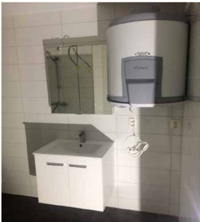
Eksempel på løsning VVbereder på bad. Mulighet for vaskemaskin under bereder.
