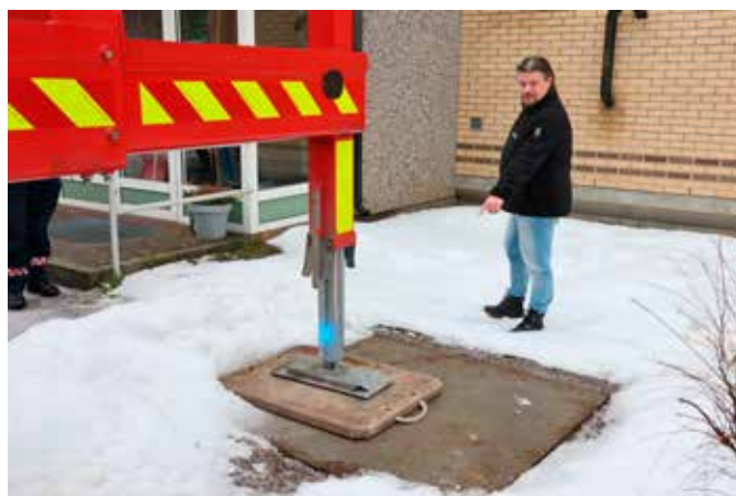
Rune Sand, teknisk sjef i KOBBL, viser frem den ene plattingen som borettslaget har støpt spesielt for at stige bilen til Glåmdal Brannvesen skal kunne brukes i redningsarbeid. På hvert sted det er klargjort for stige bilen er det støpt fire plattinger, en for hver av stige bilens støttebein.
