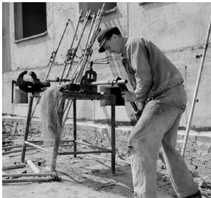
Rørleggere i arbeid. Foto: Wikipedia
