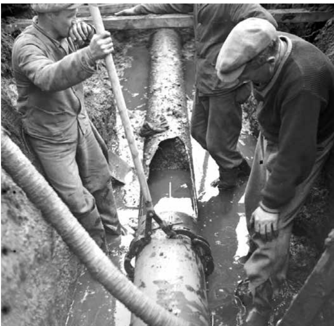
Rørleggere i arbeid. Foto: Anno Museum
